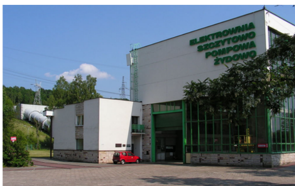
RYS.4. ELEKTROWNIA SZCZYTOWO-POMPOWA ŻYDOWO
