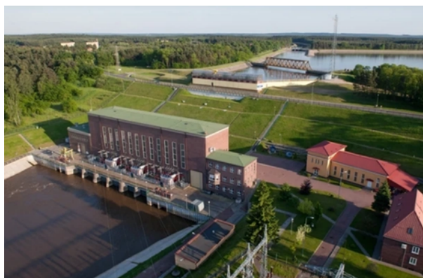
RYS.7. ELEKTROWNIA SZCZYTOWO-POMPOWA W DYCHOWIE
