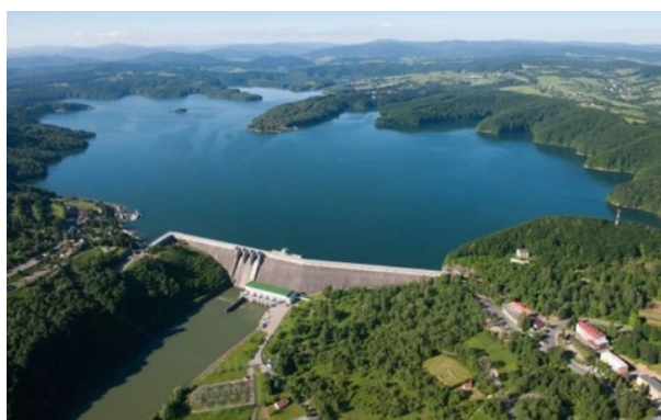
RYS.5. ELEKTROWNIA SZCZYTOWO-POMPOWA W SOLINIE
