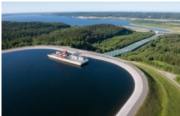
RYS.2. ELEKTROWNIA SZCZYTOWO-POMPOWA W ŻARNOWCU
