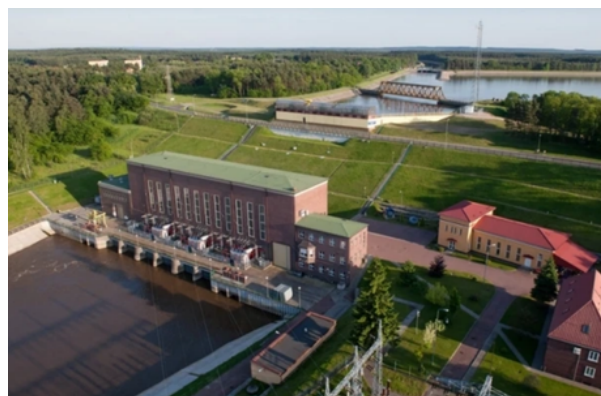
RYS.7. ELEKTROWNIA SZCZYTOWO-POMPOWA W DYCHOWIE
